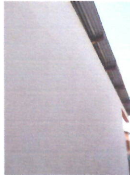
ESTRUCTURA DE TECHO, MANTENIMIENTO DE ESTRUCTURA
