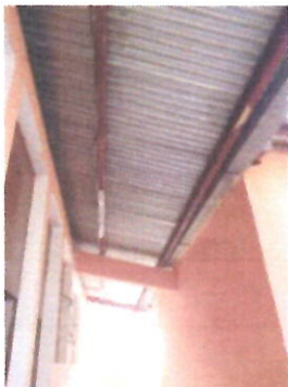
CUBIERTA DE LAMINA, SUSTITUCION DE LAMINA ONDULADA POR LAMINA TROQUELADA
